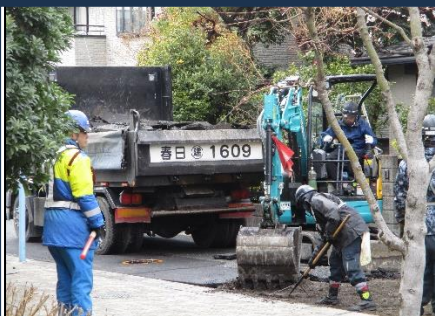
仮養生道を掘り起こし
