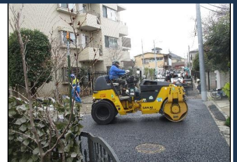
熱い内にローラで踏み固め
