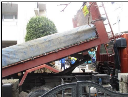
温めたアスファルトを整地機投入
