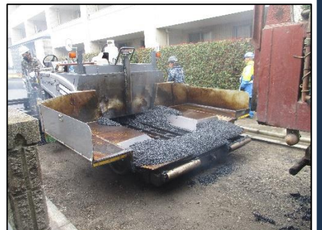
左: ダンプカー, 中央: 整地機に投入, 右: 整地機上のアスファルト
