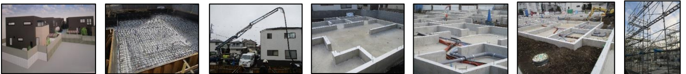
① 8/20 業者内明 ② 10/20 基礎配筋 ③ 10/30 コンクリート充填 ④ 11/6 基礎工事完成 ⑤ 11/14 配管配線工事 ⑥ 11/20 庭への土入れ ⑦ 12/4 仮設足場
