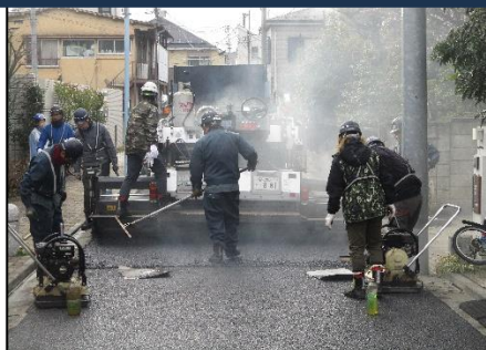
アスファルトを路上へ撒き整地
