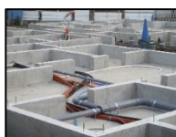
⑤ 11/14 配管配線工事
