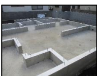
④ 11/6 基礎工事完成
