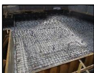
② 10/20 基礎配筋
