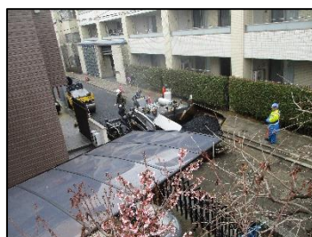
左: ダンプカー, 中央: 整地機に投入, 右: 整地機上のアスファルト
