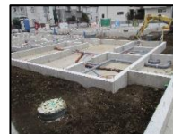
⑥ 11/20 庭への土入れ
