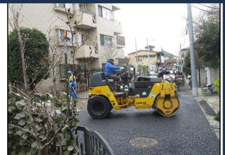
熱い内にローラで踏み固め
