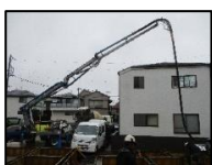
③ 10/30 コンクリート充填
