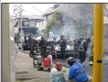
温めたアスファルトを整地機投入
