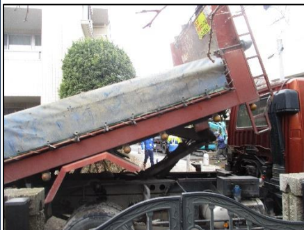
温めたアスファルトを整地機投入
