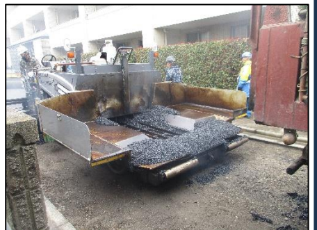
左: ダンプカー, 中央: 整地機に投入, 右: 整地機上のアスファルト
