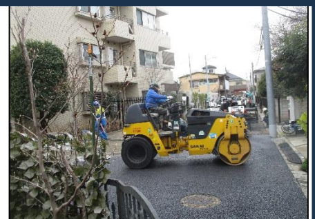
熱い内にローラで踏み固め
