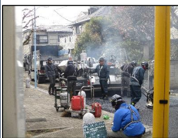
温めたアスファルトを整地機投入
