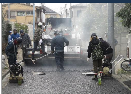
アスファルトを路上へ撒き整地
