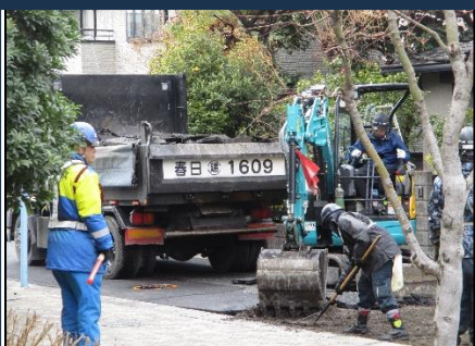
仮養生道を掘り起こし
