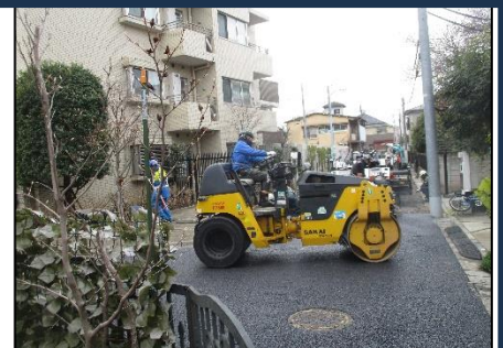
熱い内にローラで踏み固め
