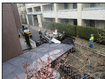
2月から自宅前の道路で**水道管(耐震管)入れ替え工事**が3回に分けて行われた。①古い管⇒仮ホース, ②仮ホース⇒耐震管, ③道路全体をアスファルトで整地でした。写真は③内容である。各15名程で、各1日で完了。(3/6)
