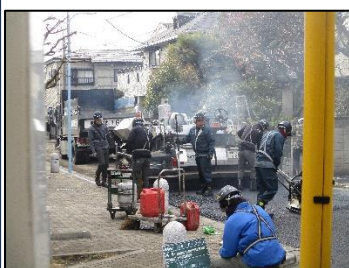
温めたアスファルトを整地機投入
