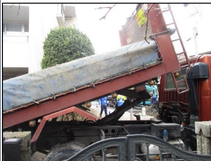
温めたアスファルトを整地機投入
