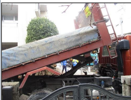
温めたアスファルトを整地機投入
